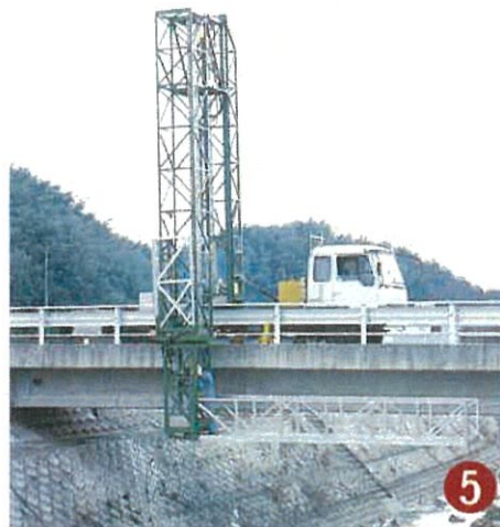
●作業姿勢の設置完了
