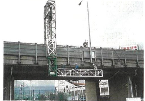
●名神高速道路での作業風景
