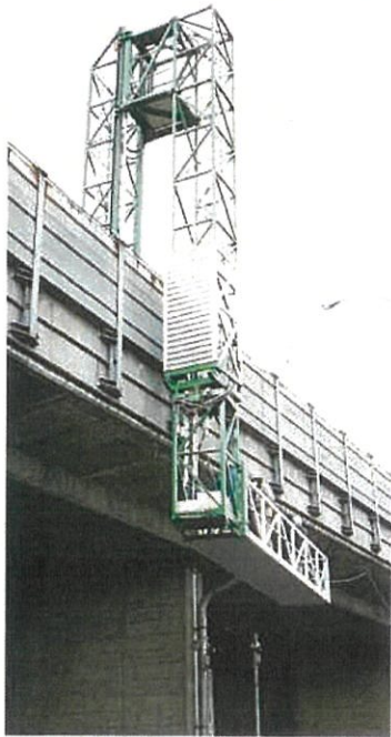
●名神高速道路での作業風景
