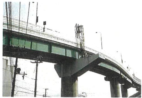
●阪神高速道路での作業風景
