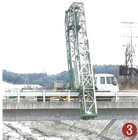
●ブーム起き上げ完了
